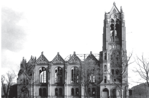
Die Auferstehungskirche vor dem Umbau
